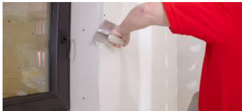
► STAP 5 afwerken van aansluitende muren
