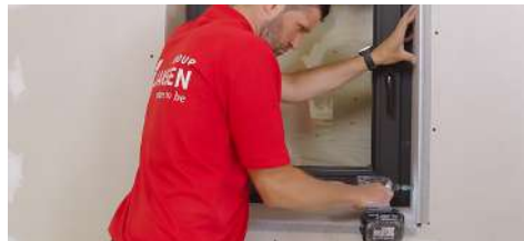
► STAP 4 plaatsing met kleefgips, schroeven of verlijming
