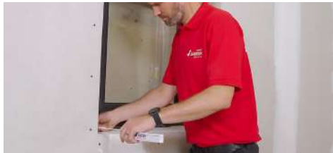
► STAP 1 meten (op verschillende plaatsen)
