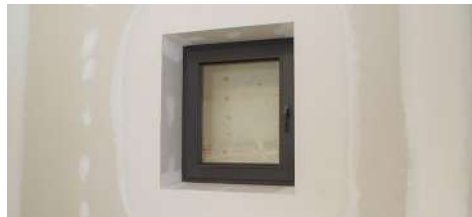
► STAP 6 afgewerkte dagkant
